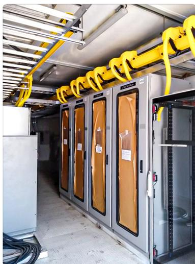
El proyecto desarrollado en la **subestación elevadora Magdalena II 34,5 / 230 kV** es un ejemplo de **instalación compacta** que aloja todos los tableros y equipos de control, protección y medida en un contenedor prefabricado.
