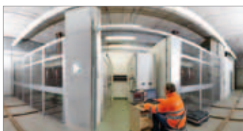
METRO BILBAO 5 INGEBER-Systeme zur Energierückgewinnung.
