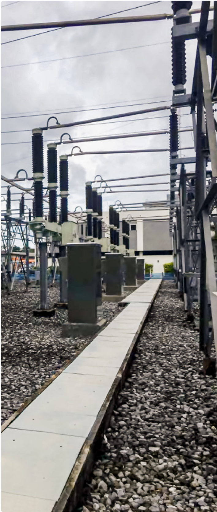
Canalización de fibra óptica del bus de proceso
