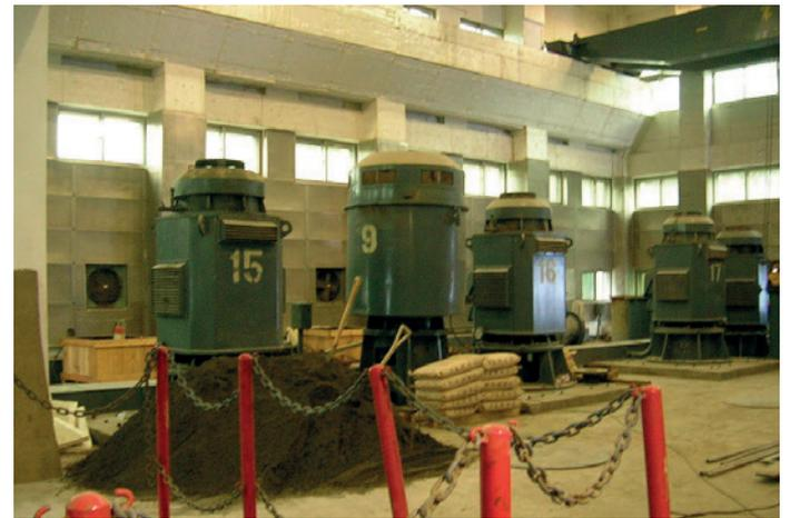
TWD comprobó un ahorro energético del 5% en rendimiento total con los grupos Indar comparado con las bombas de eje vertical y también obtuvo significativo ahorro en la operación y mantenimiento de los equipos.
