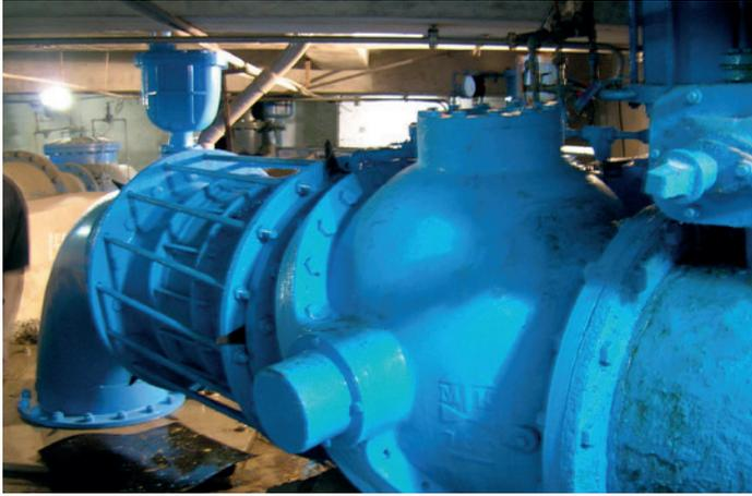
Indar propuso grupos respetuosos con el medio ambiente, más ligeros en peso, diseño compacto listo para ser instalado (sin necesidad de alineaciones), menor desgaste y mantenimiento más sencillo, menos espacio requerido, menos costes de instalación (reducción de diámetros y optimización de geometría), IP68 (sin riesgo de corto circuito), auto-lubricantes y auto-refrigerados, etc.
