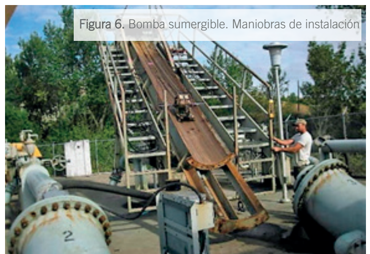
Figura 4. Bomba sumergible. Maniobra de instalación
