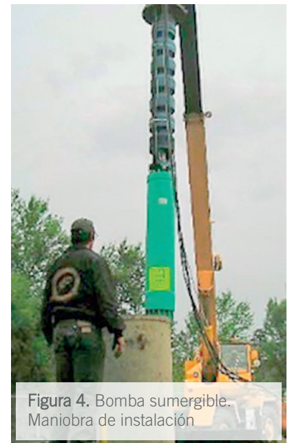
Figura 6. Bomba sumergible. Maniobras de instalación
