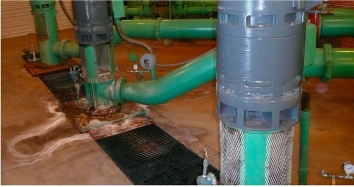
Debido a la limitación de espacio (altura y longitud) no era posible proporcionar el nuevo caudal requerido de 2,725 m<sup>3</sup>/h con las bombas verticales tradicionales. Se seleccionaron las bombas y motores invertidos de INDAR para cumplir con este requerimiento.
