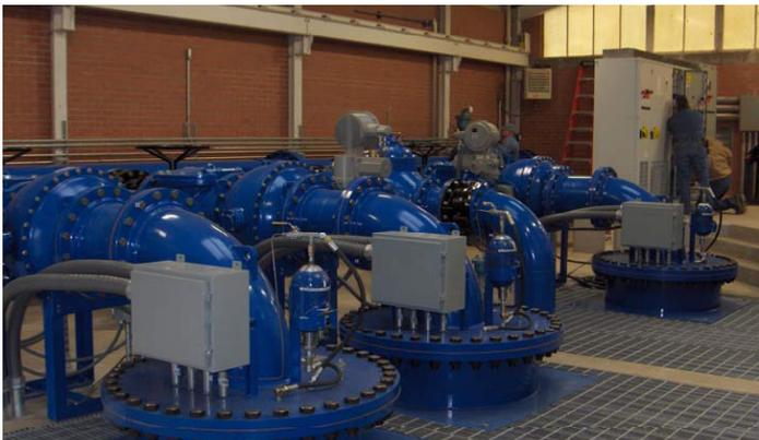
Esta fotografía muestra las tres bombas sumergibles de 225kW en línea.
