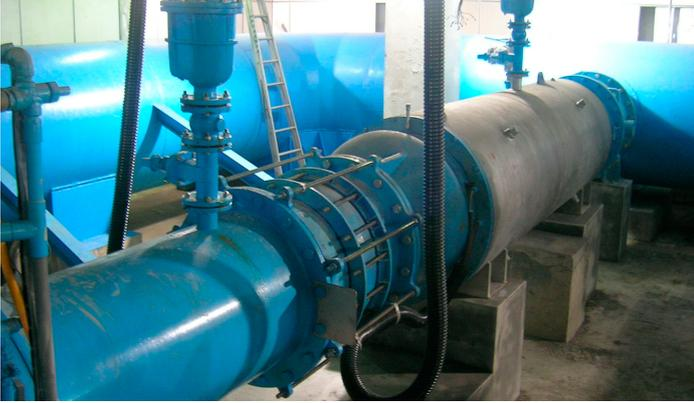
El espacio requerido por las bombas horizontales era menor que la requerida por las de tipo vertical. Y los viejos motores generaban muchísimo ruido y calor. Los grupos sumergibles de Indar en configuración horizontal entre tuberías resolvieron todos estos inconvenientes.
