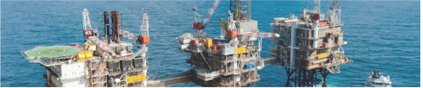
La plataforma ULA está situada a 70 m de profundidad. El embalse principal se eleva a 3.345 m en la formación Ula del Jurásico superior. Este campo tiene tres instalaciones convencionales de acero para la producción, perforación y barracas habitables. Cuenta con 7 pozos de producción y 2 de inyección de agua. La producción actual del campo de Ula es de 10.000 barriles al día.
