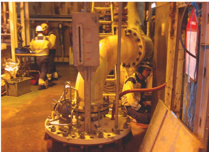
Los nuevos motores sumergibles fueron fabricados de acuerdo a las exigentes normas NORSOK, siendo los materiales según M-650 y la pintura de acuerdo a M-501. Las bombas sumergibles existentes sufrían de corrosión prematura. Indar fue seleccionada para proporcionar la solución al problema. Así, todas las bombas de elevación de agua de mar fueron sustituidas y éstas incluían motores sumergibles Indar.
