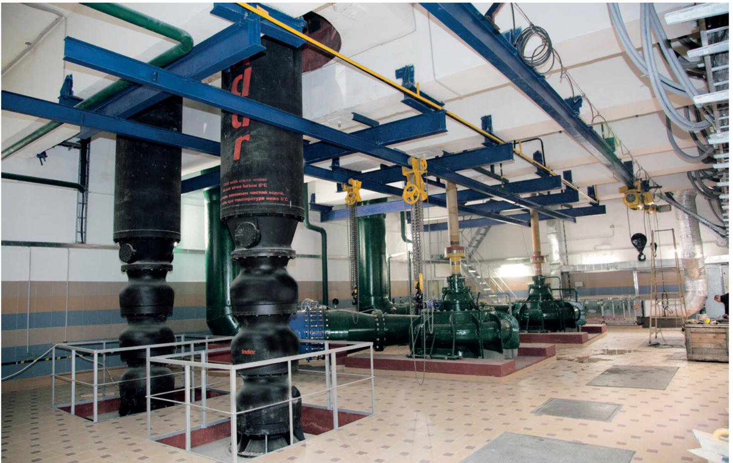
**Figura 3.** Primera estación de bombeo de elevación de la planta de suministro de agua de Zapadnaya después de la modernización. Dos bombas sumergibles.
