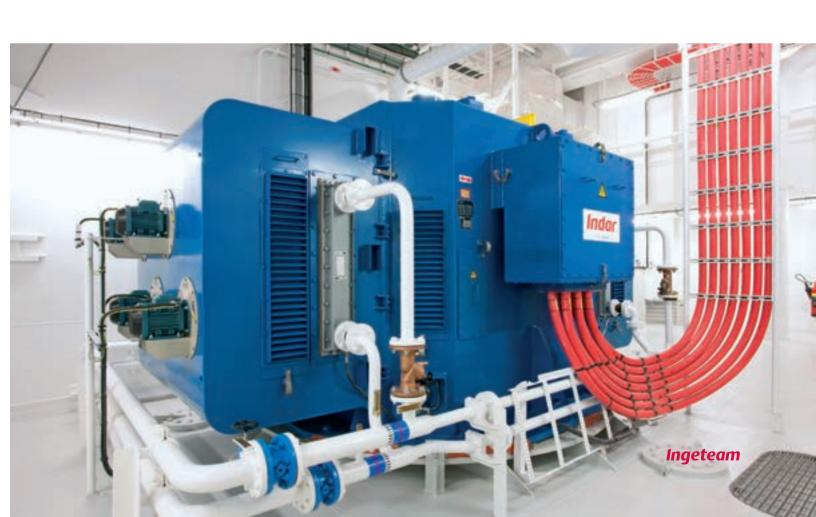
Sistema de Potencia Integrado Compacto y de Alta Eficiencia para Buques de Propulsión Eléctrica
