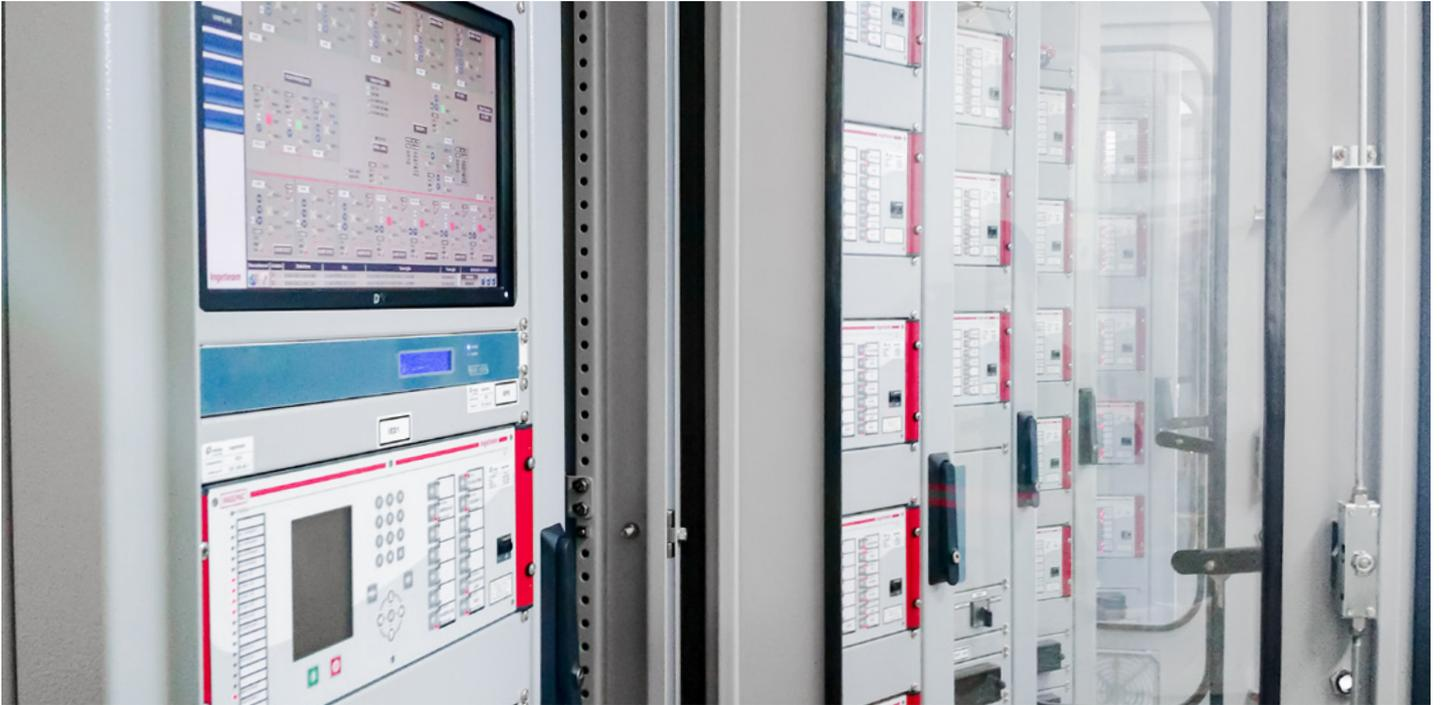
Ingeteam ofrece soluciones de control basadas en la **norma IEC 61850**, que se componen de dispositivos electrónicos inteligentes (IED) que controlan cada una de las posiciones eléctricas y que sirven los datos recogidos a un sistema **SCADA** que permite operar, programar, analizar y reportar los datos de toda la subestación, tanto de manera local como remota.
