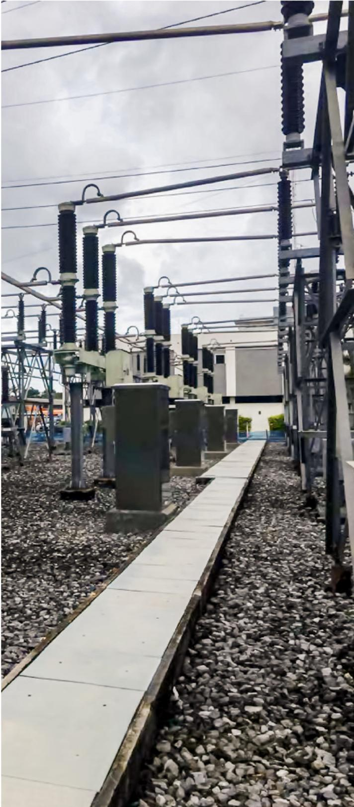
Canalización de fibra óptica del bus de proceso
