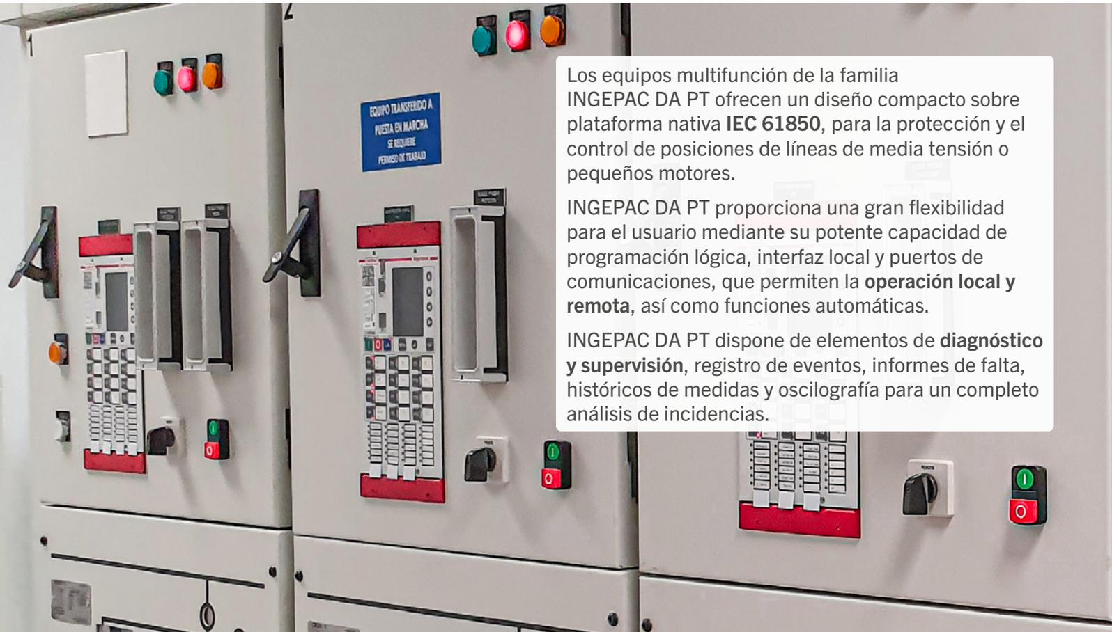
Los equipos multifunción de la familia INGEpac DA PT ofrecen un diseño compacto sobre plataforma nativa IEC 61850, para la protección y el control de posiciones de líneas de media tensión o pequeños motores.
