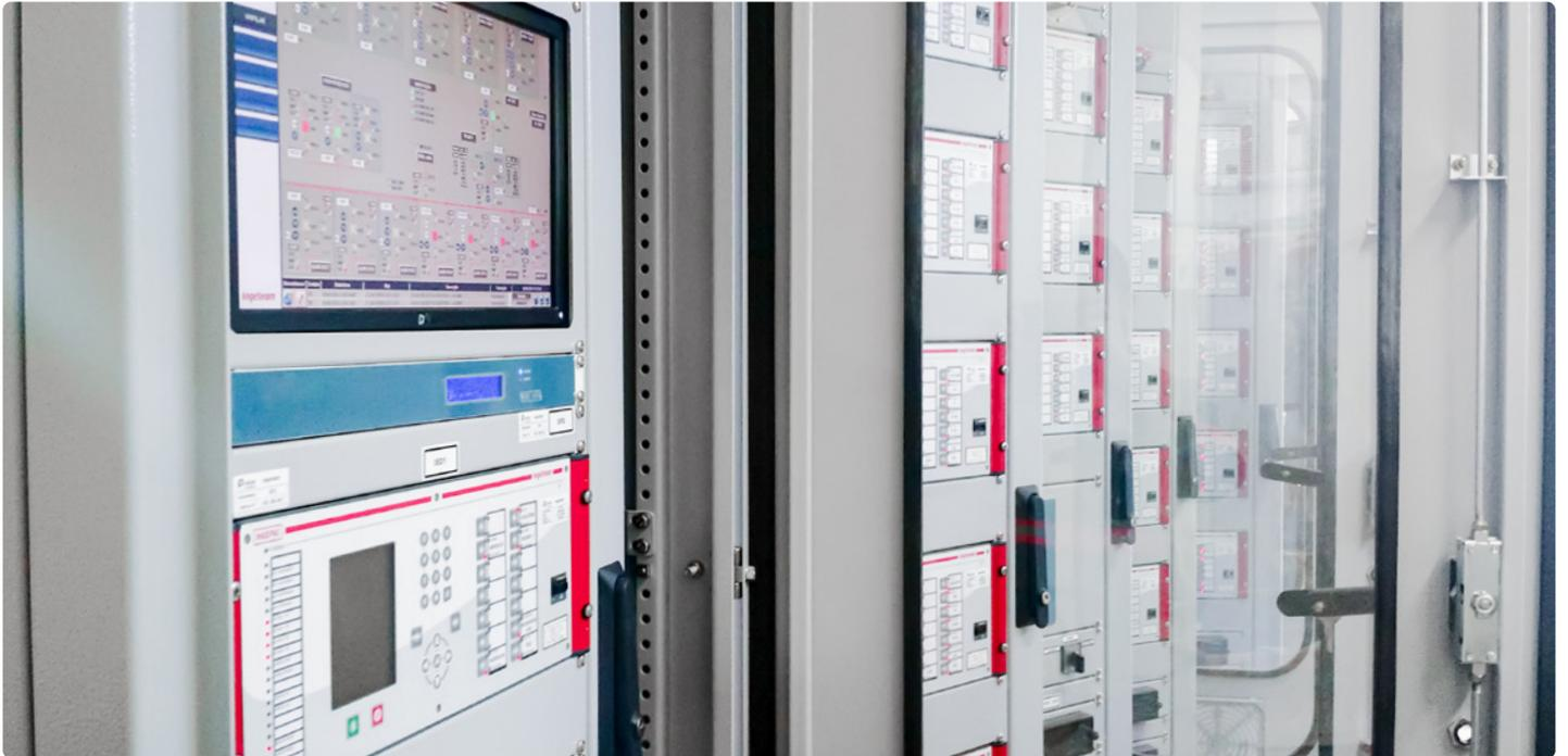
Ingeteam ofrece soluciones de control basadas en la **norma IEC 61850**, que se componen de dispositivos electrónicos inteligentes (IED) que controlan cada una de las posiciones eléctricas y que sirven los datos recogidos a un sistema **SCADA** que permite operar, programar, analizar y reportar los datos de toda la subestación, tanto de manera local como remota.
