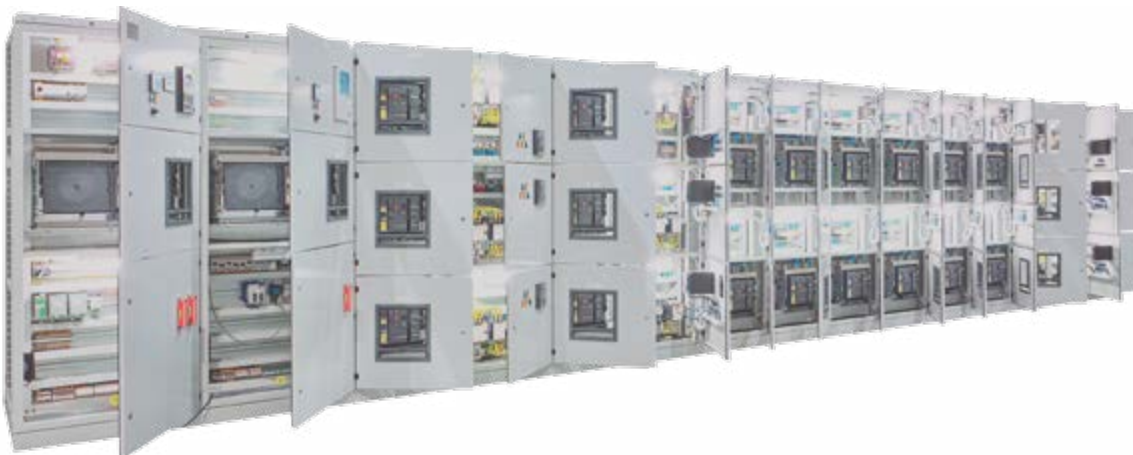
Cuadro general de distribución de Baja Tensión
