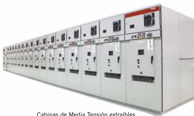
Cabinas de Media Tensión extraíbles
