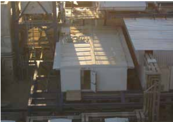
INSTALACIÓN EN TERRENO
