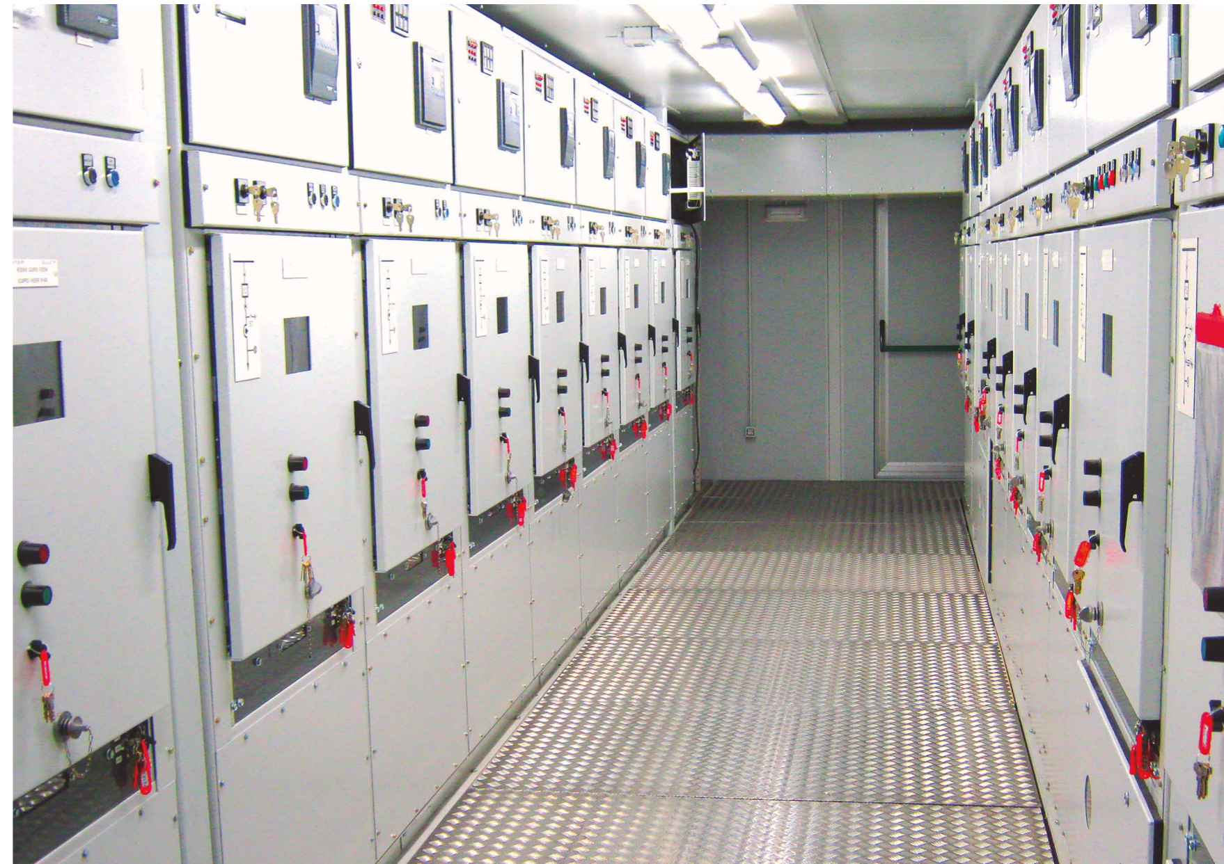
Cabinas de media tensión en contenedor
