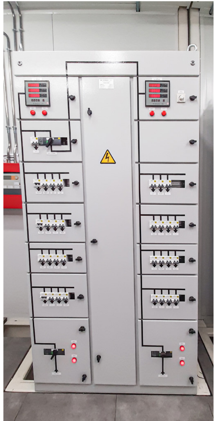
Armarios de servicios auxiliares
