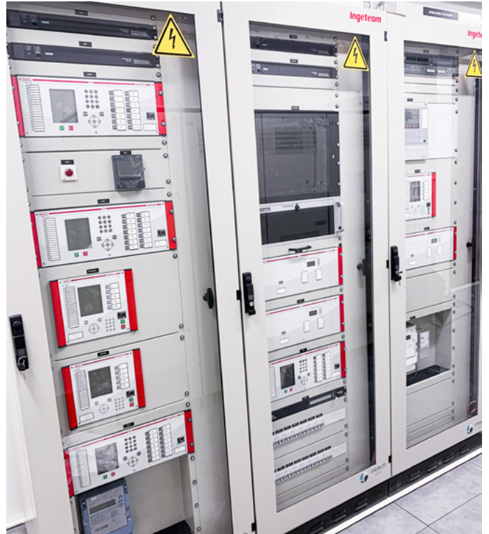
Armarios del sistema de protección y control
