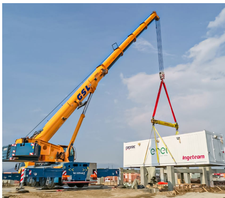
Descarga de la caseta con grúa telescópica
