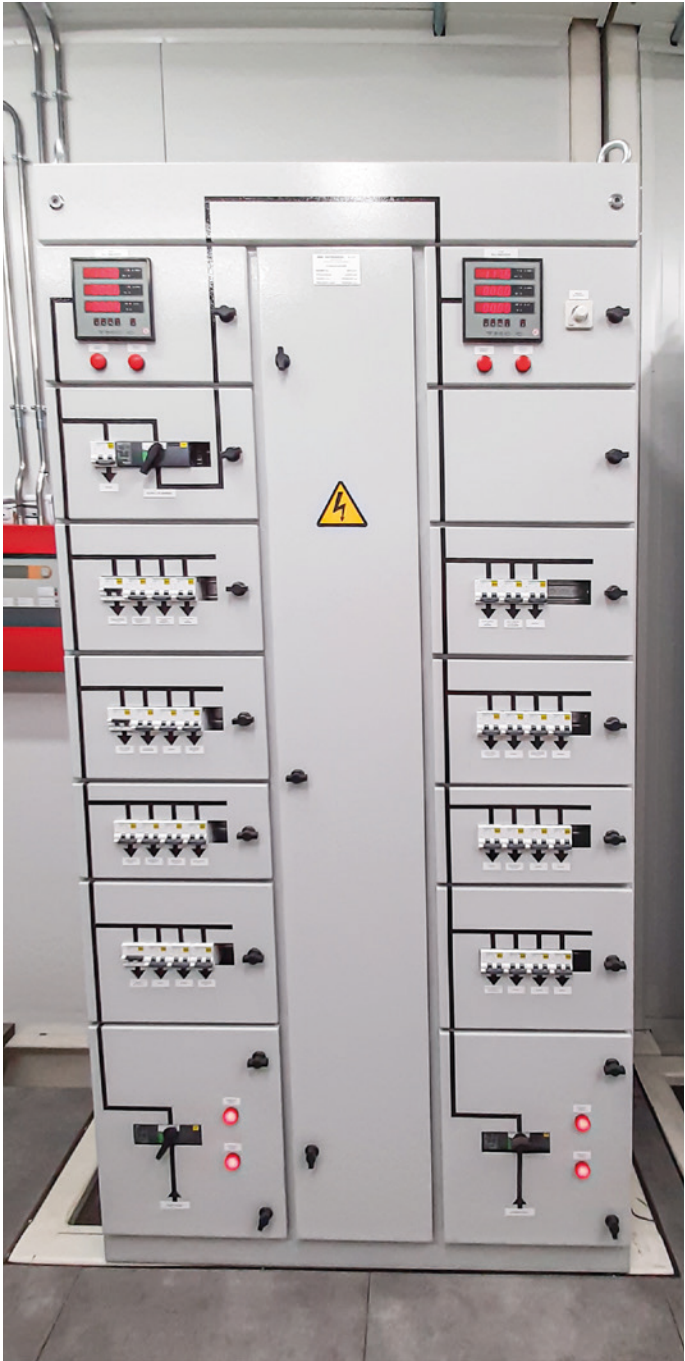
Armarios de servicios auxiliares
