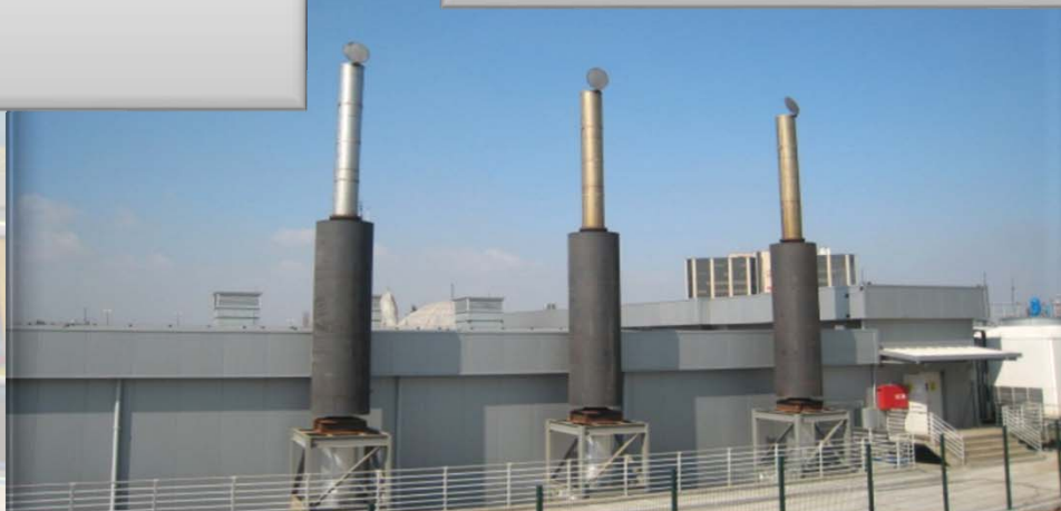
Sector Terciario: Hoteles, Hospitales, Aeropuertos...
